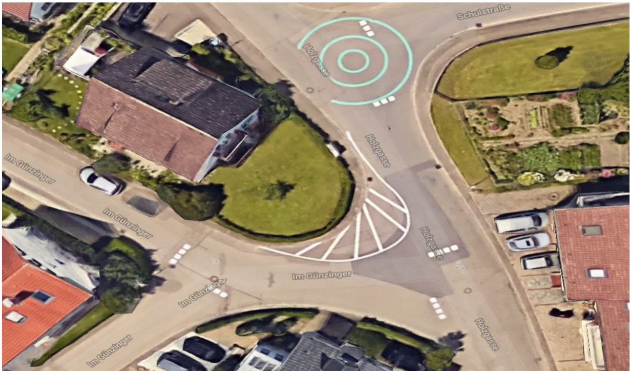
Bild 4.2: Beispiel Wartelinien bei "Rechts-vor-Links" in Allensbach (Quelle: Google)
