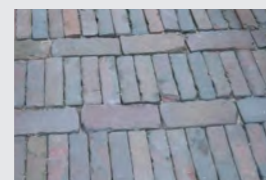
Klinkerläufer im Flechtverband
