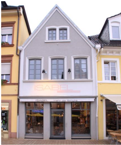
Schaufensterteilung auf darüber liegende Fassade abgestimmt
