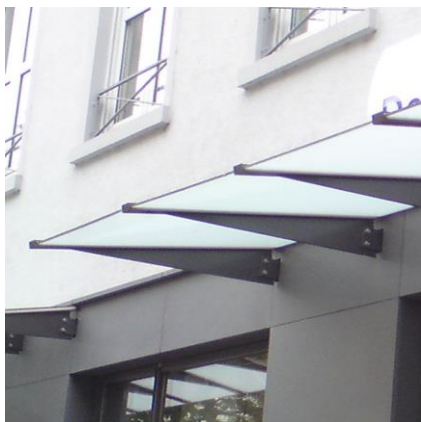
Glasvordächer bieten Schutz und verschatten nicht die Schaufensterzone
